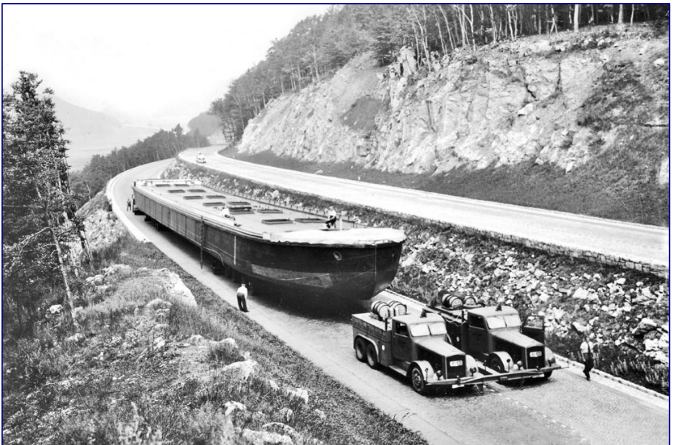
Die mit maximal 8 km/h verkehrenden und damit kaum schneller als Schrittgeschwindigkeit fahrenden Schwertransporte gaben für den mitreisenden Fotografen viele Gelegenheiten zum Ablichten. Hier umkurvt eine solche Einheit mit einem Schiffsrumpf am 29. Mai 1940 auf der Reichsautobahn den Kindinger Berg. Foto: RVM, Archiv Eisenbahnstiftung
