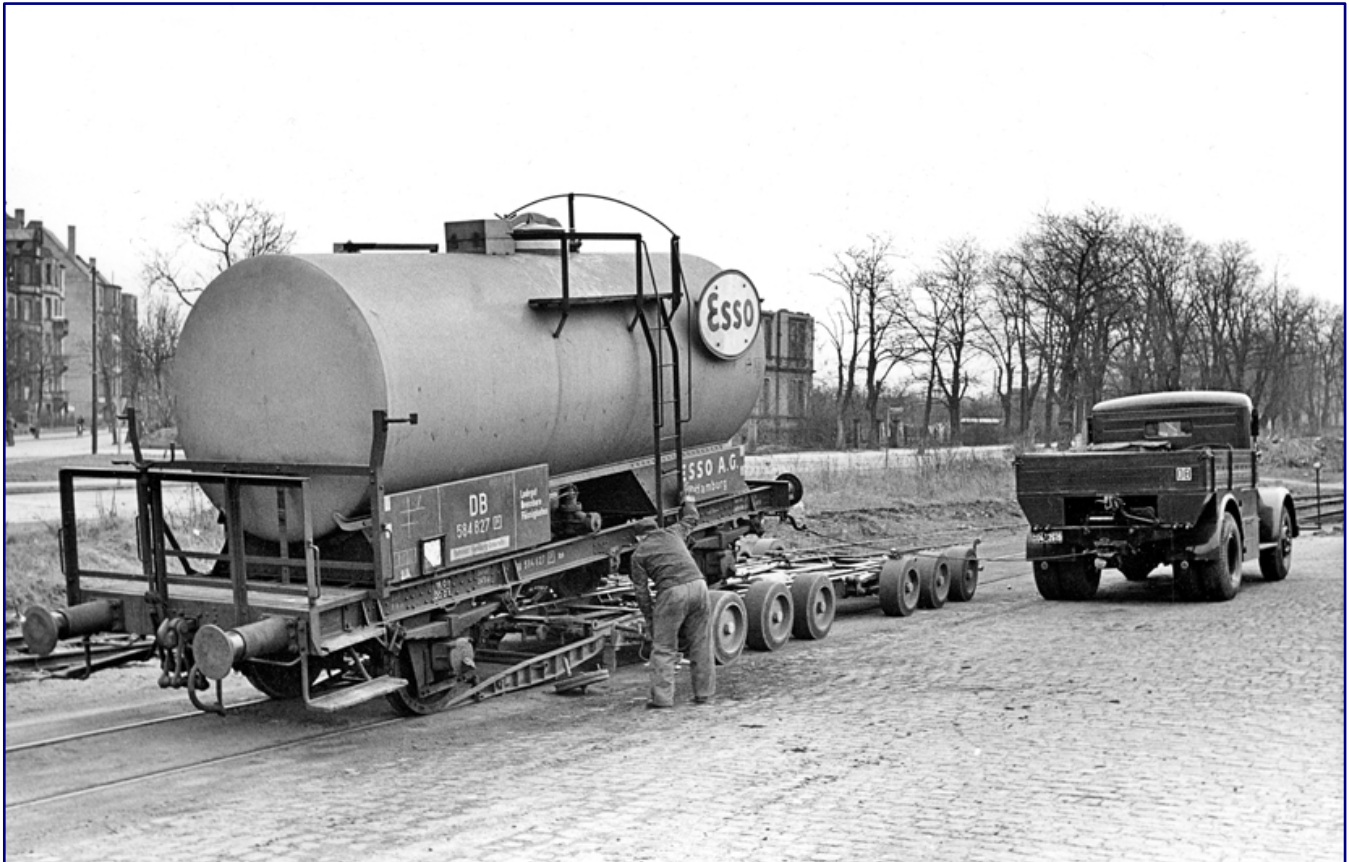
Den Culemeyer-Transporten kam nach 1945 zunächst eine wichtige Funktion beim Wiederaufbau und folgenden Wirtschaftswunder zu. Hier wurde 1956 im Bahnhof Hanau im Bild festgehalten, wie die Kaelble-Zugmaschine mittels Seilwinde und Auffahrrampe einen Kesselwagen der deutschen Esso AG auf ihren sechsachsigen Straßenroller aufnimmt. Foto: Paul Trost, Archiv Eisenbahnstiftung
