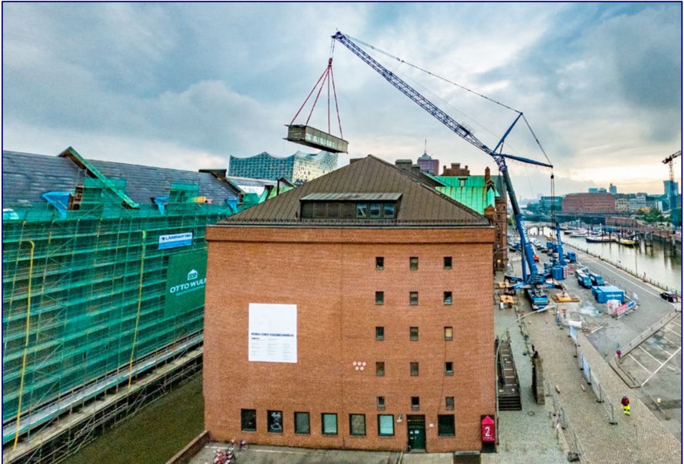
Der zweitgrößte Mobilkran Europas hebt die 39 Tonnen schwere Brücke in den frühen Morgenstunden des 15. Juli 2020 40 Meter hoch über das Speichergebäude. Foto: Miniatur-Wunderland.
