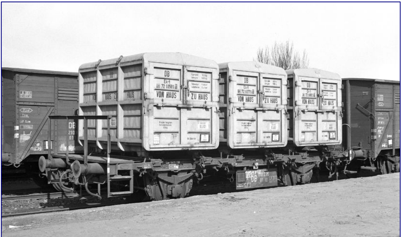
Die Behältertragwagen BT 10 entstanden durch Umbau auf alten Fahrwerken von gedeckten Wagen der Gattungen G 10 und G(r) 20. Zwei solcher Spenderfahrzeuge der erstgenannten Bauart stehen im März 1961 in Kassel neben und hinter dem Tragwagen mit der Betriebsnummer 010 235. Foto: Reinhard Todt, Eisenbahnstiftung
