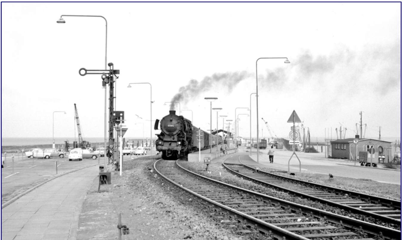
Nordeich ist der einzige Kur- und Erholungsort an der ostfriesischen Küste, der direkt an das Netz der Bahn angeschlossen ist. Am 9. Januar 1967, also ein Jahr vor der computergerechten Umzeichnung, wartet 01 1072 in unmittelbarer Nähe der Fähranleger auf Abfahrt. Foto: Detlev Luckmann, Eisenbahnstiftung
