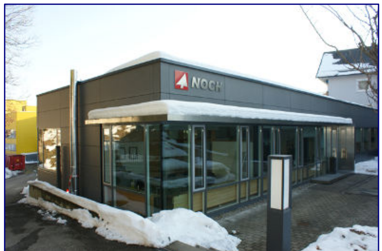
Im März berichteten wir von einer Werksbesichtigung bei Noch in Wangen (Allgäu) – im Bild das Verwaltungsgebäude der Firma.
