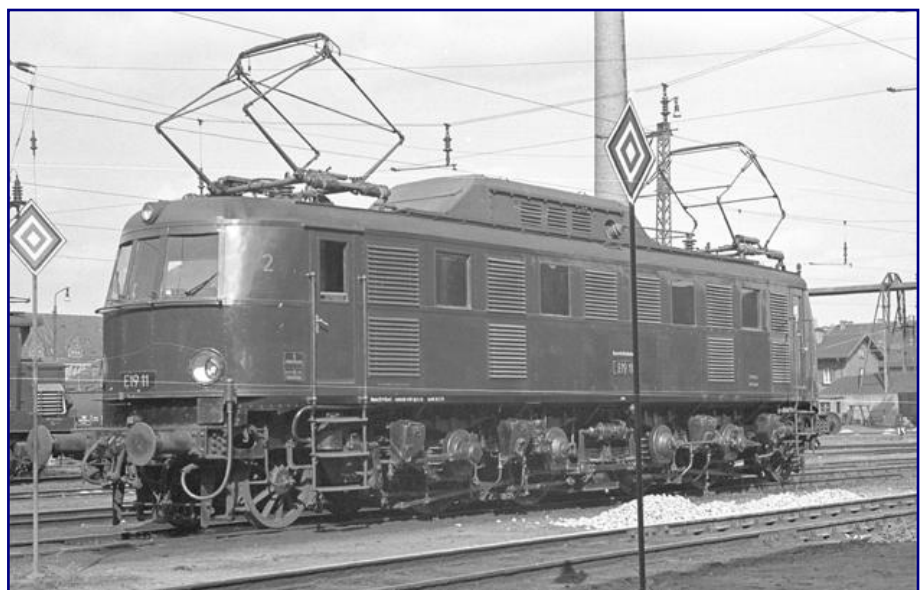
Als E 19 11 um 1959/60 in ihrem Bw Nürnberg Hbf aufgenommen wurde, trug sie zwei verschiedene Pantographen, wie hier gut zu sehen ist: einen SBS 39 über Führerstand 2 (hier vorne) und einen Stromabnehmer der Bauart HISE 2 am gegenüberliegenden Ende. Foto: Walter Patzke, Sammlung Petkelis
