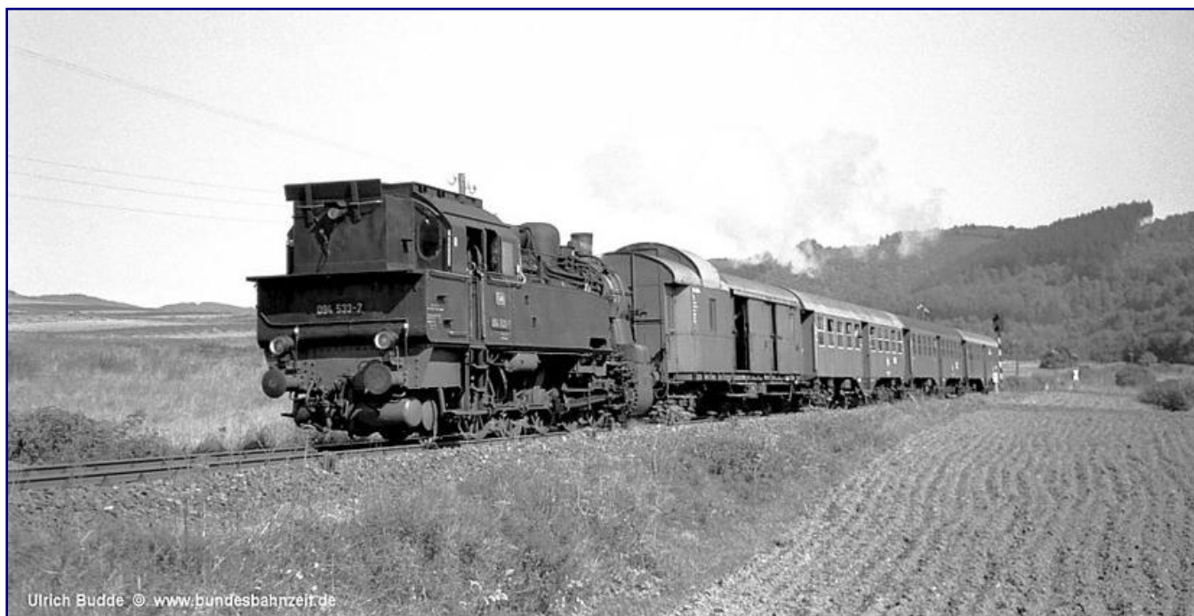
Das Bw Dillenburg setzte seine Vierundneunziger bis 1972 im Personenzugdienst auf Steilstrecken ein. So eignet sich auch diese Garnitur als Anregung für die Modellbahn. Typisch ist der geschweißte Kohlenkastenaufsatz, der das Fassungsvermögen erheblich vergrößerte. Foto: Ulrich Budde (Bundesbahnzeit)
