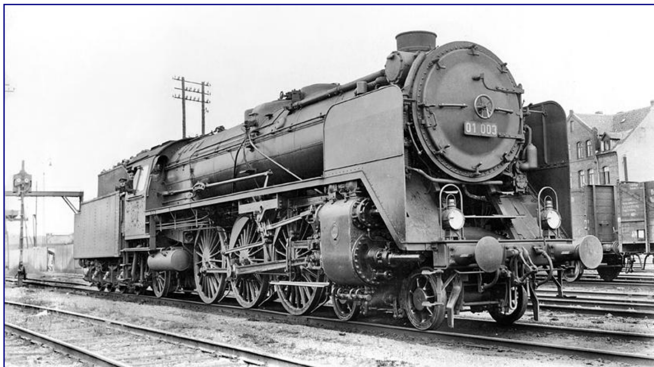
01 003 gehörte zu den ersten Einheitslokomotiven der Baureihe 01. Am 8. April 1930 besitzt sie immer noch die Gasbeleuchtung und kleinen Wagner-Bleche, mit denen sie Anfang 1926 geliefert wurde. Die Lok vom Bw Hamm P wendete an diesem Tag in Hannover. Foto: Rudolf Kreuzer, Sammlung Eisenbahnstiftung
