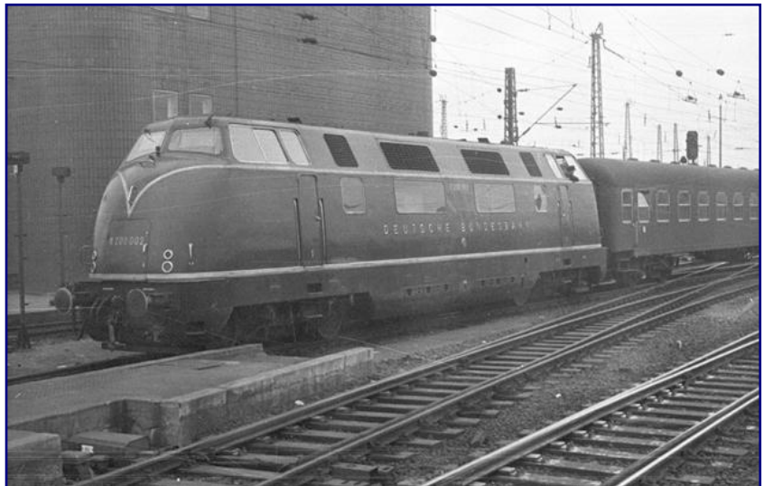
In ihren ersten Dienstjahren wurde hier die Vorserienlok V 200 002 vor dem Zentralstellwerk Frankfurt (Main) Hbf abgelichtet: Sie trägt noch kein drittes Spitzenlicht, die Frontklappe ist noch in alter Ausführung vorhanden und die kleinen Maschinenraumbenutzerfenster sind einteilig ausgeführt. Foto: Walter Patzke, Sammlung Petkelis
