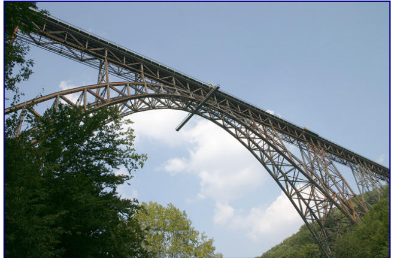
Ein Indiz, dass die Deutsche Bahn AG ohne „Beförderungsfälle“ – bisweilen auch als Kunden bezeichnet – rechnet, ist die jüngst abgeschlossene Sanierung der Müngstener Brücke – Deutschlands höchster Eisenbahnbrücke. Foto: Christian Olsen
