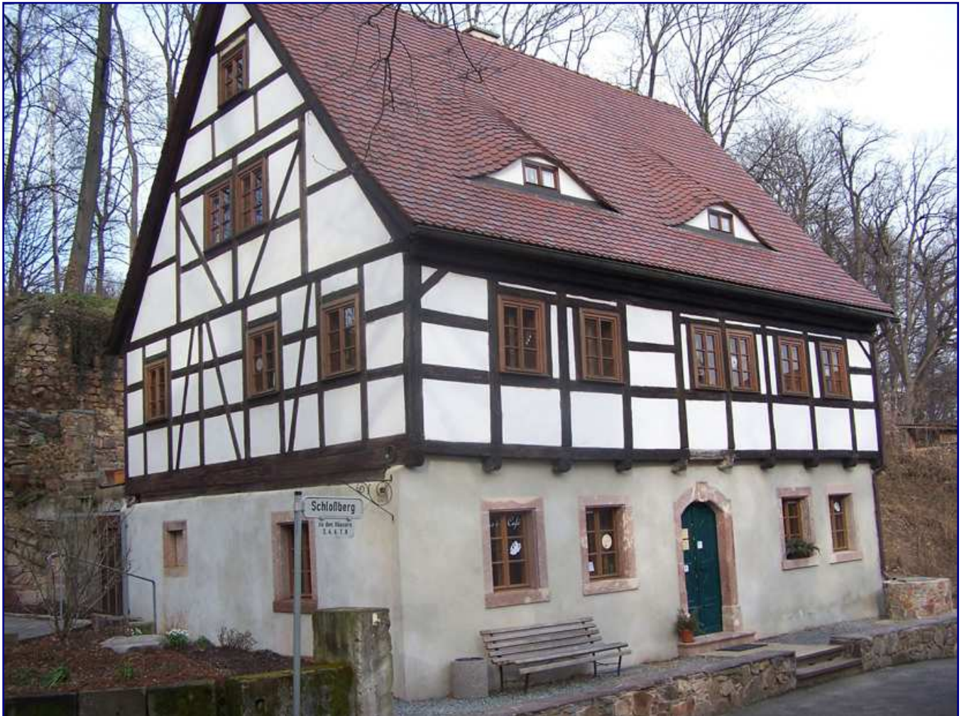
Die Vorlage für das Bauvorhaben: Das idyllische Fachwerkhaus aus dem Jahr 1705 am Schloßberg 8 in Chemnitz lieferte die Anregung. Foto: Wilfried Pflugbeil
