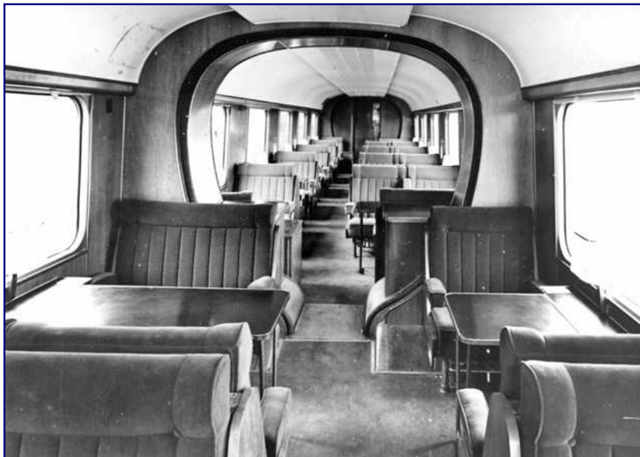
Ungewöhnlich war die Großraumwagengestaltung, die auch an den Übergängen nicht Halt machte: Der Blick fällt durch den Bogen über dem Einachsdrehgestell auf den nächsten Wagen. Foto: LHB, Sammlung Dr. Rolf Löttgers
