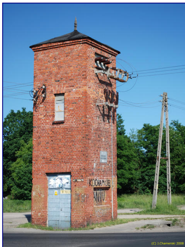
Dieses Backstein-Trafohaus „Brick“ nach polnischem Vorbild erscheint 2009 neu bei Hugwa & wiygN als Resinbausatz mit geätzten Ansetzteilen. Foto: Hugwa & wiygN, J. Chamerski
