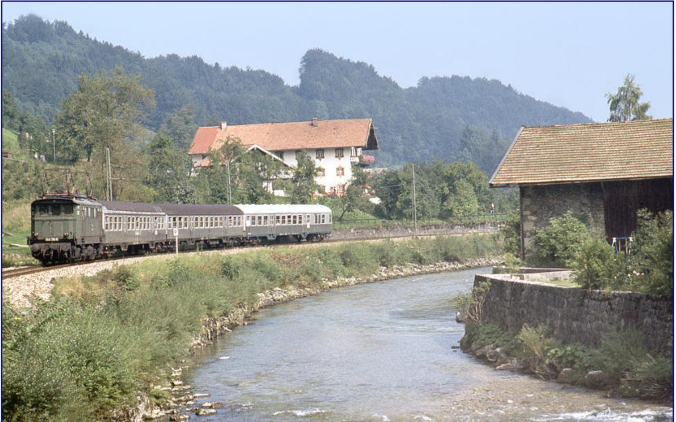
**Die Entwicklung der Wendezüge endete vorerst bei den Silberlingen mit 36-poliger Steuerleitung und den „Hasenkästen“ als übliche Kopfform. Ein aus solchen Wagen gebildeter Zug ist mit 144 185-6, Pionierlok für die direkte Wendezugsteuerung bei der DB, am 30. April 1979 am Traunufer bei Eisenärzt (Strecke Traunstein – Ruppolding) unterwegs. Foto: Peter Schiffer, Slg. Eisenbahnstiftung**
