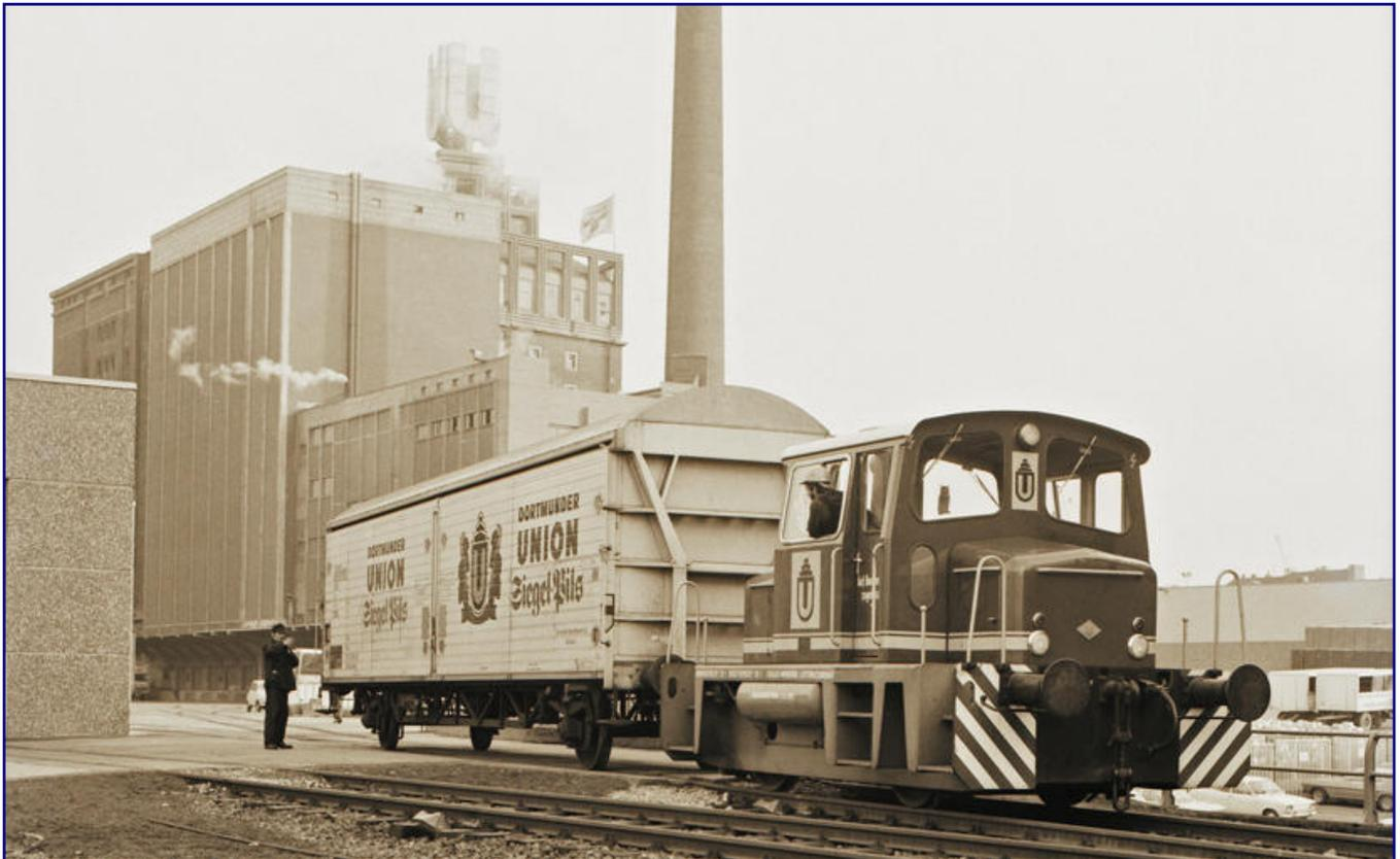
Schiebewandwagen waren die modernsten Wagen der Dortmunder Union-Brauerei. Sie eigneten sich vor allem für das Beladen mittels Gabelstapler. Am 13. Februar 1974 wird einer dieser Vertreter auf dem Firmengelände rangiert. Im Hintergrund ist das Kühlkellerhochhaus mit dem weithin sichtbaren U zu sehen. Foto: Foto-Studio Harald Koechlin (Archivnummer 1545-15)
