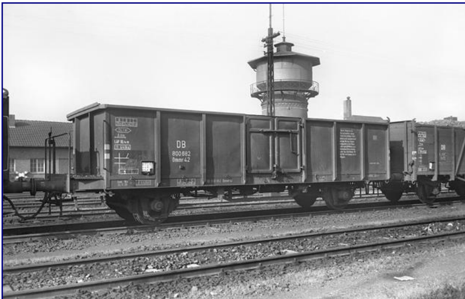
Der Ommr 42 war an seinen außenliegenden Langträgern zu erkennen und leicht von anderen Bauarten zu unterscheiden. Der Waggon mit der Betriebsnummer 800 682 wurde 1960 in Rheydt abgelichtet. Foto: Fischer, Slg. Eisenbahnstiftung
