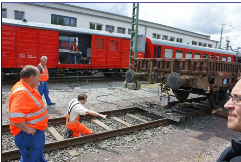
Die Mannschaft vom Hilfszug führte vor, wie ein entgleister Güterwagen wieder sicher auf die Schienen zurückgesetzt werden kann – sogar ganz Kranhilfe.
