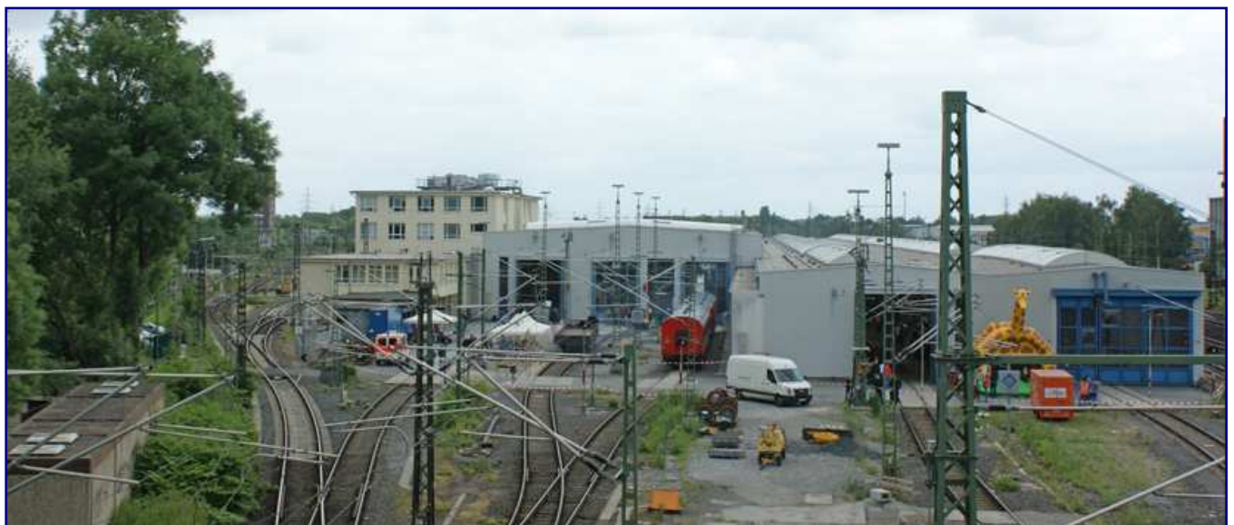
Die Fahrzeughallen und ein Teil des Außenbereiches bildeten das Veranstaltungsgelände des ICE-Werks Dortmund-Spächenfelde.
