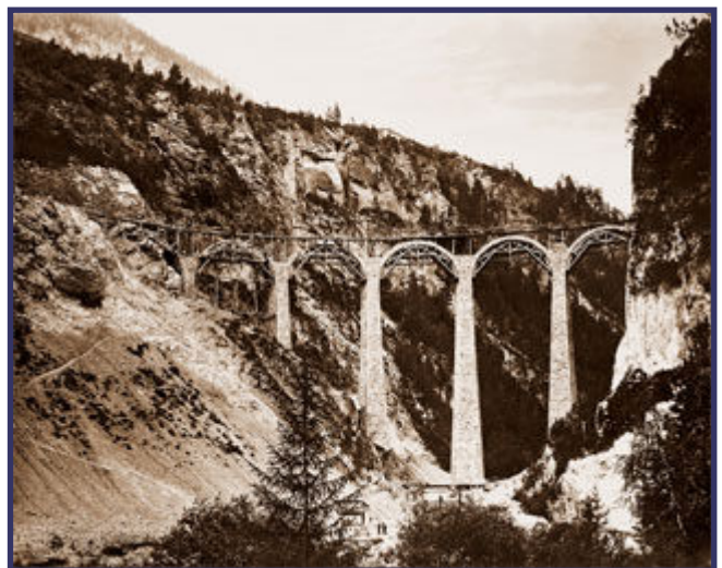
Das Landwasser-Viadukt entsteht: Zu sehen sind die Pfeiler mit Lehrgerüsten © Rhaetische Bahn, Chur
