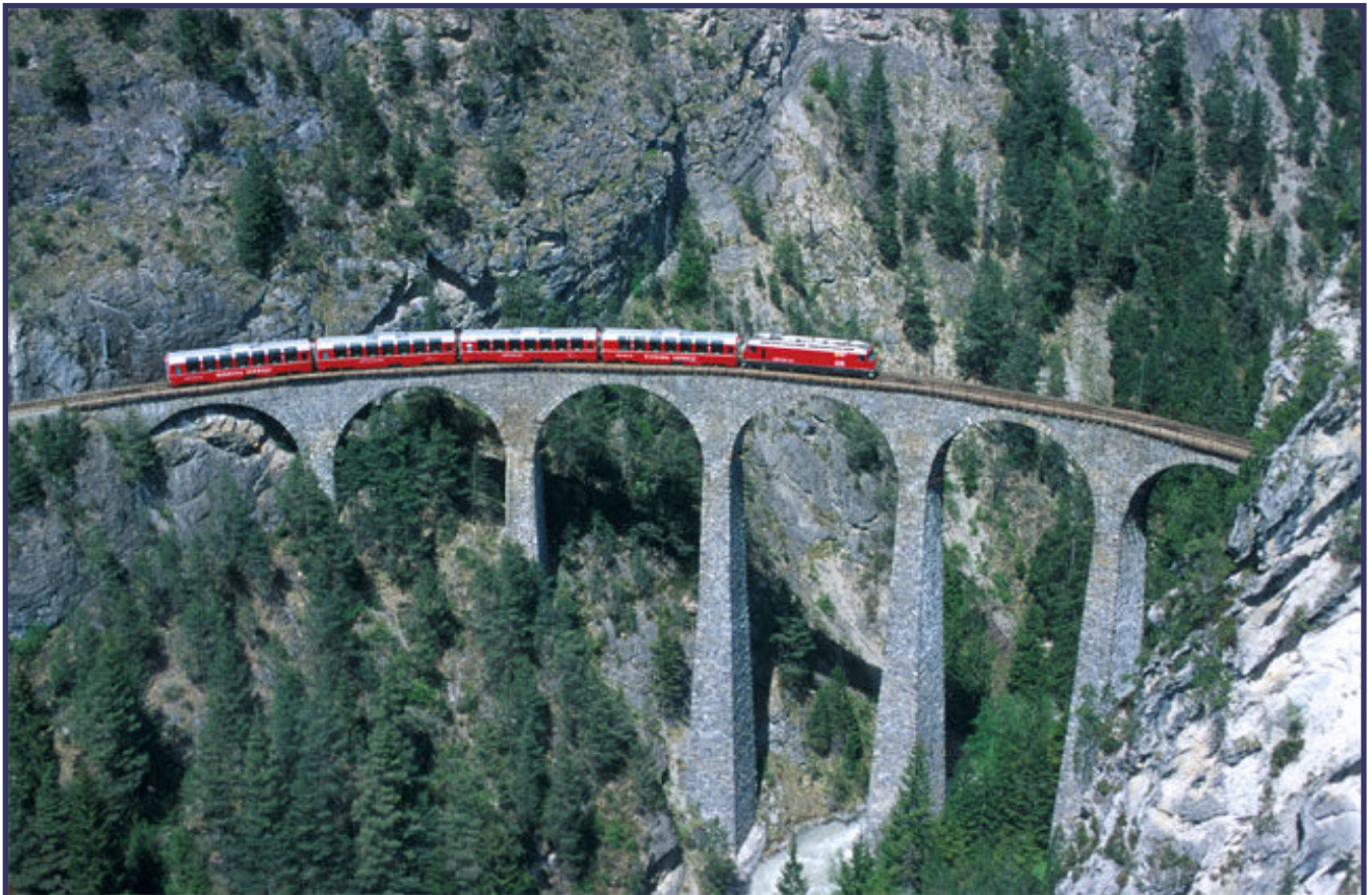
Diese Luftaufnahme zeigt den Bernina-Express mit Panoramawagen auf dem berühmten Landwasser-Viadukt von Filisur, wie es bis heute erhalten blieb. Es ist zusammen mit den Krokodilen Ge 6/6 I das wohl berühmteste Wahrzeichen der Rhätischen Bahn. Foto P. Donatsch, Bad Ragaz © Rhaetische Bahn, Chur
