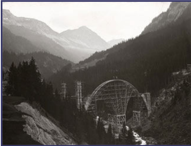
Langwieser-Viadukt im Bau (1906-1908): eine der größten Steinbogenbrücken Europas © Rhaetische Bahn, Chur
